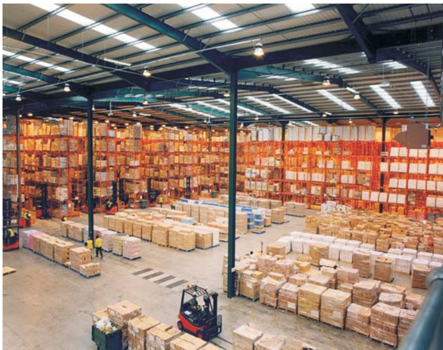
Rysunek 4.1. Magazyn z wydzielonymi strefami niskiego i wysokiego składowania
