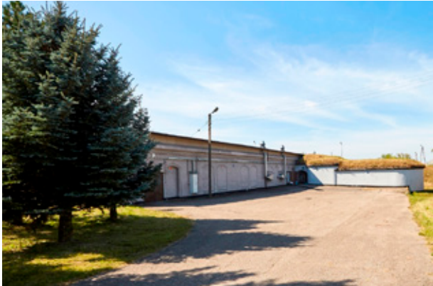
Fot. 2. Obiekt nr 1 w KSOP w Różanie
