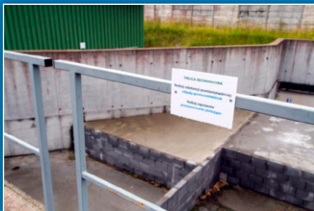
Obiekt numer 8 służący do składowania odpadów nisko- i średnioaktywnych krótkożyjących
