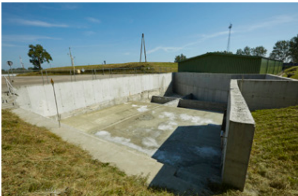
Fot. 3. Obiekt nr 8 służący do składowania odpadów nisko i średnioaktywnych krótkozyciowych
