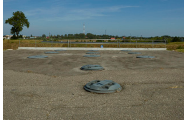
Fot. 4. Komory obiektu numer 3a
