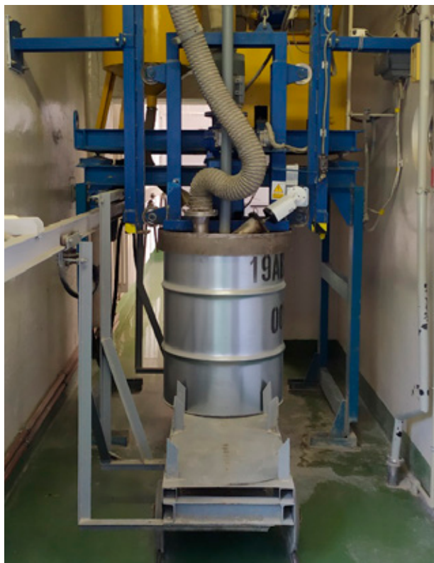
Fot. 6. Instalacja cementowania podczas pracy Photo 6. Cementing installation during operation
