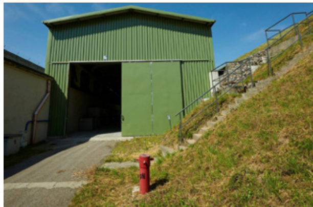
Fot 6. Piezometr służący do poboru próbek wody gruntowej na terenie składowiska
