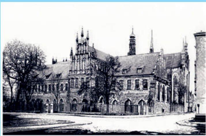
Il. 1. Budynek Gdańskiego Gimnazjum Akademickiego (rys. Andrzej Taranek)
